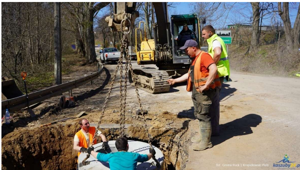
17. Roboty przy budowie kanalizacji
